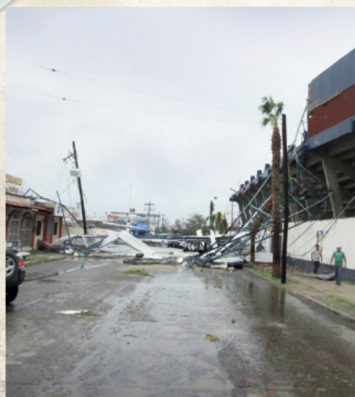
› Destrozos en La Paz por las fuertes lluvias del huracán Odile (2014)
