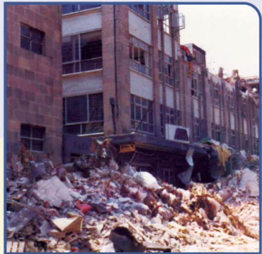
► Derrumbe de un edificio por terremoto, calzada de Tlalpan (1985)
