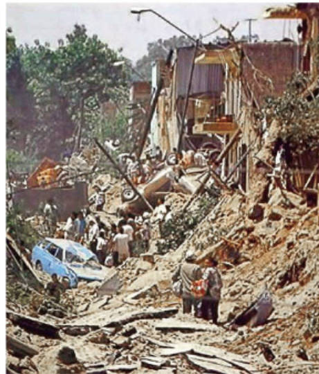
› Casas y calles destruidas por explosiones en el drenaje ocasionadas por derrame de gasolina. Guadalajara, Jalisco (1992)
