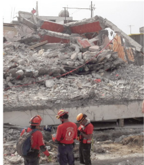
› Edificios colapsados por terremoto. Ciudad de México (2017)
