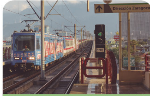
Estación del metro en Monterrey (2020)
