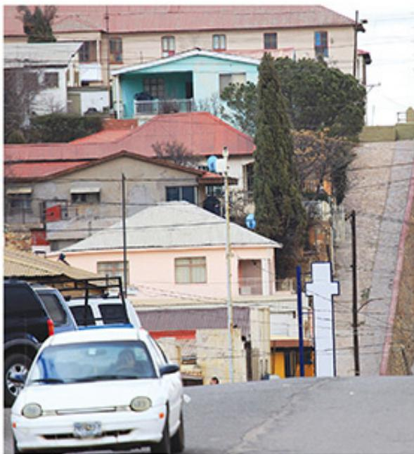
En la región de Cananea, las nevadas son muy frecuentes, por eso la mayoría de las casas tienen techos de lámina, pues este material es muy resistente. Usualmente, las láminas se colocan a dos aguas, esto quiere decir que el techo tiene una elevación con forma de triángulo, lo que permite que la nieve se derrita, el agua escurra y no entre a las casas.
