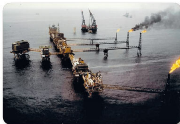
Figura 3.20 El complejo de Cantarell en la sonda de Campeche, en las aguas del golfo de México, es un conjunto de plataformas de extracción de petróleo. Actualmente, sólo produce 82000 barriles diarios. Plataforma petrolera.
